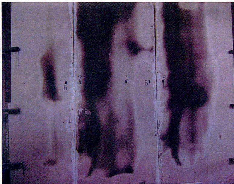
Фото №3. Образец №2. Перегородка с двухслойными обшивками из гипсостружечных плит ГСП толщиной 12 мм. на одинарном металлическом каркасе, толщиной 123мм. после проведения испытания.
