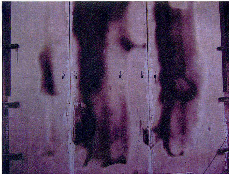
Фото №2. Образец №1. Перегородка с двухслойными обшивками из гипсостружечных плит ГСП толщиной 12 мм. на одинарном металлическом каркасе, толщиной 123мм. после проведения испытания.
